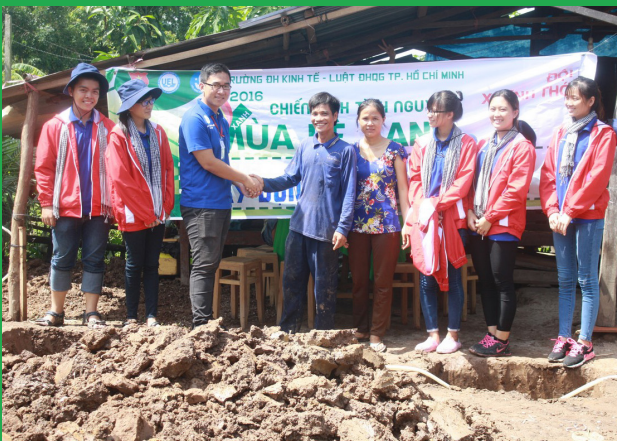
Khởi công xây dựng nhà tình thương
